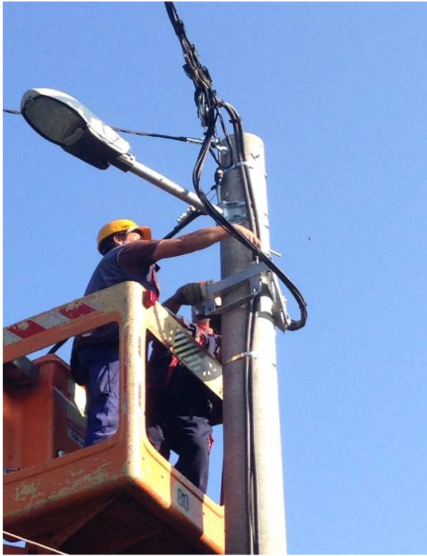
1. Instalación del soporte para VROT-18-3
