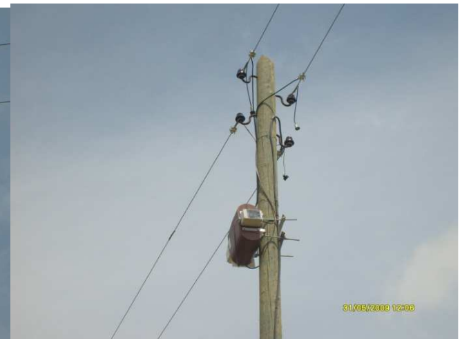
6. La protección de sobretensiones por descargas atmosféricas, VROT-18-1 no está dañado
