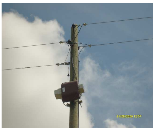
5. VROT-18-1 instalado en el poste
