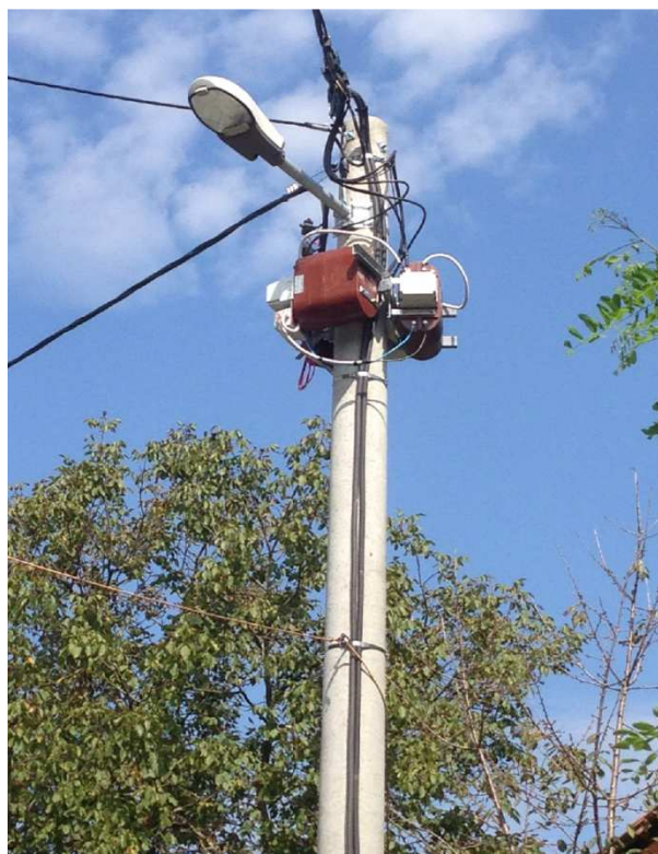
2. VROT-18-3 instalado y energizado
