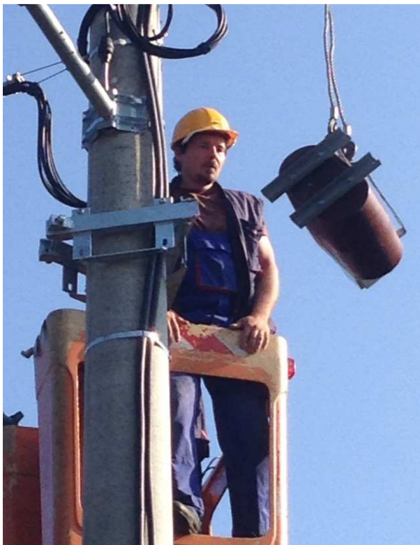
3. Montaje VROT-18-3 en el poste
