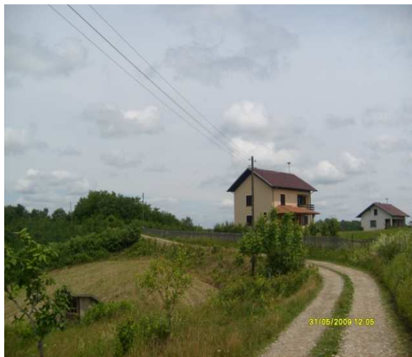
1. Lugar de instalación VROT-18-1 en alimentación LV desde la subestación
