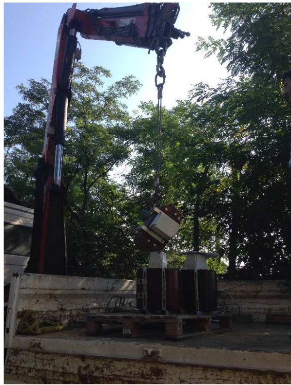
2. Elevación, VROT-18-3 en poste
