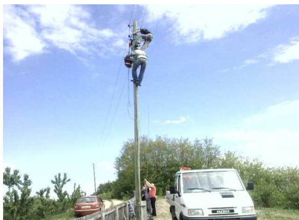
3. Elevación VROT-18-1 en poste
